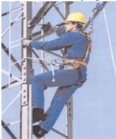
3 pav. tvirtinimas darbo vietoje
